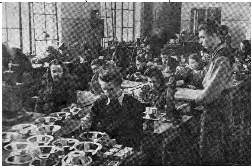
Radiocechā plaši izmanto konveijera sistemu, uz konveijera tiek samontēti ne tikai uztvērēji, bet arī to mezgli. Uzņēmumā: skaļruņu montāžas konveijers meistara Baumana iecirknī.
